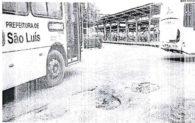
Buracos nas vias das plataformas retratam a situação em que se encontra o Terminal da Praia Grande
