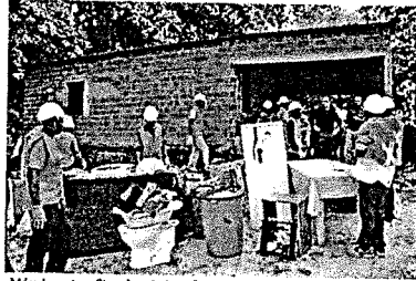
Móveis e utensílios domésticos foram retirados das casas, antes de os operários do Porto São Luís iniciarem as demolições
