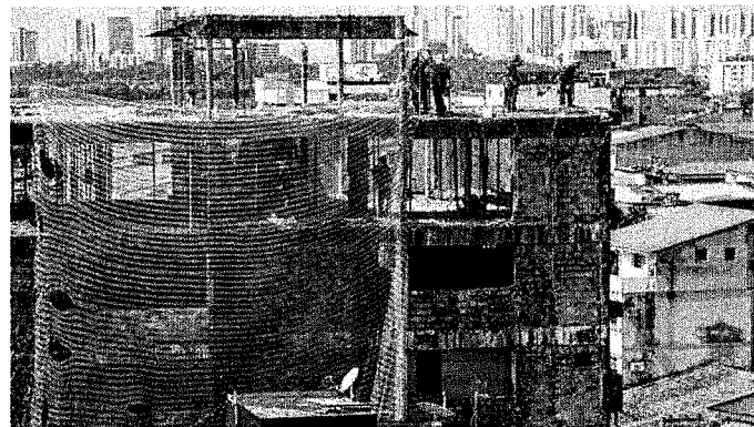
Equipes começaram o trabalho de demolição manual do prédio, que fica localizado no São Francisco
