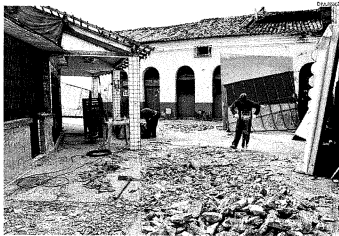
O Mercado das Tulhas ganhará um novo piso, de acordo com a reforma que está sendo executada
