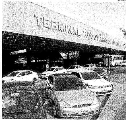
Impasse continua, e a rodoviária continua com obras paralisadas
