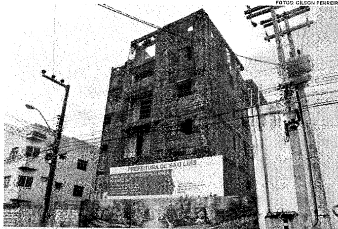
Construído na década de 90, por uma empresa cearense, que decretou falência, o “Balança, mas não cai” passou muitos anos ocupado irregularmente e agora está, finalmente, sendo demolido pela Prefeitura de São Luís
