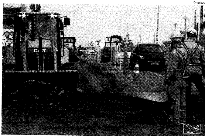
Obras para a instalação do BRT são realizadas pelo Governo do Estado na Avenida dos Holandeses
