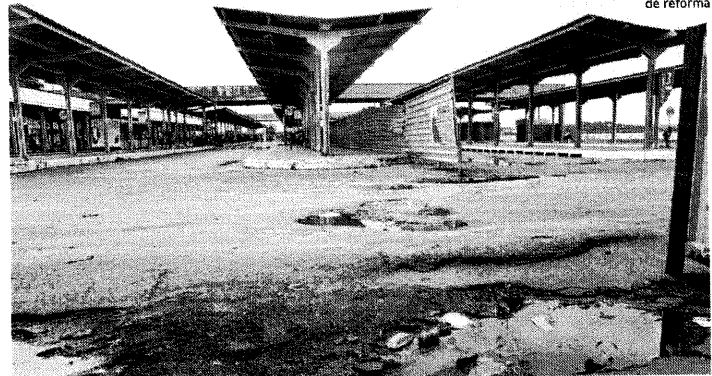
OBRAS nas plataformas 3 e 4 ainda não estão prontas; plataformas 1 e 2 ainda precisam de reforma
