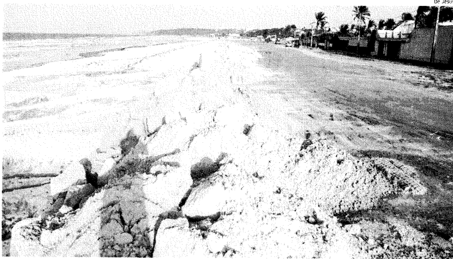
Obras do novo prolongamento da Avenida Litorânea, aparentemente paradas, podem ser embargadas caso pendência não seja resolvida
