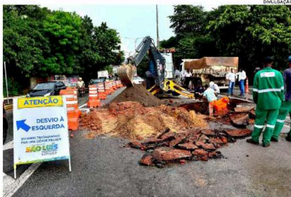
Equipes da Semosp e da Caema trabalham para recuperar trecho da Av. Jerônimo de Albuquerque
