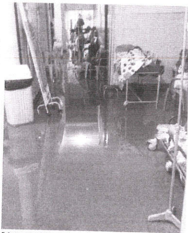
Pelo corredor do hospital, onde já se acumulam macas, havia água
