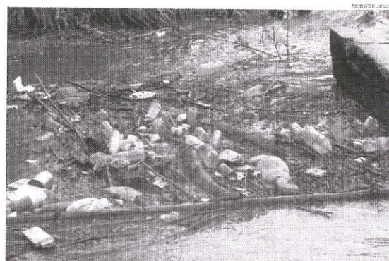
Lixo se acumula ao lado de galeria no Cohafuma; quando chove, areia alaga e sujeira entope bueiro
