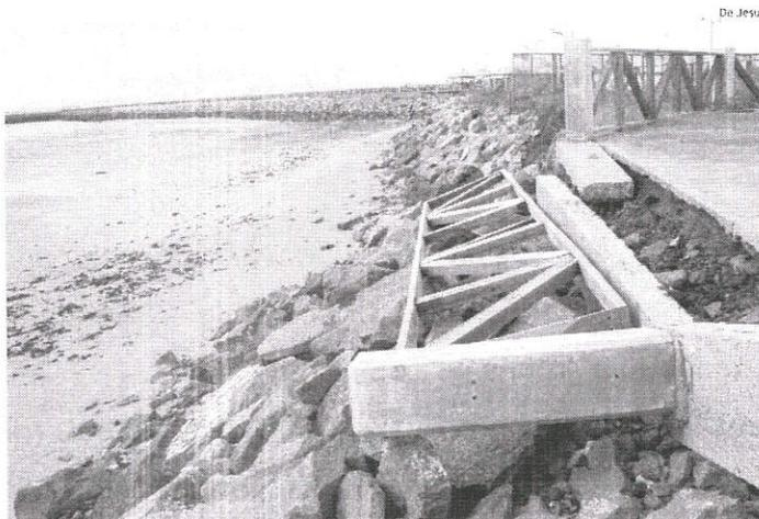
Parte da mureta de proteção do espigão desabou com a erosão causada pela falta de manutenção
