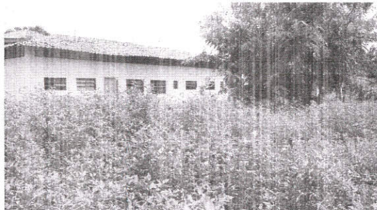
Unidade Integrada Doutor Aquiles Lisboa, na Rua Bom Jesus, está fechada e mata cobre toda a área
