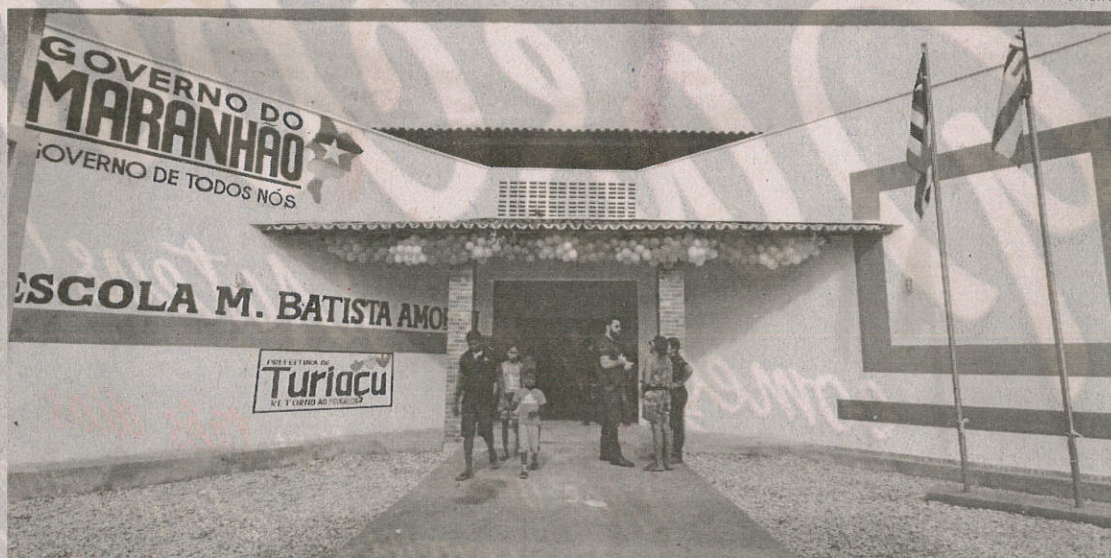
Escola do povoado Bananal, no município de Turiaçu, após reestruturação pelo Escola Digna
