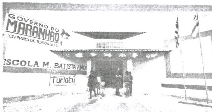
Os novos prédios, que serão entregues totalmente mobiliados, substituem antigas estruturas de taipa e palha
