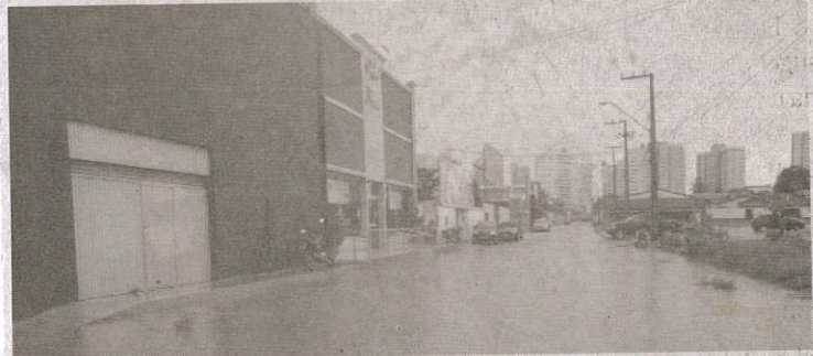
Rua dos Maçaricos, na Ponta do Farol, também ficou alagada
