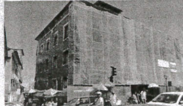
O PRÉDIO DO HOTEL RIBAMAR, NO INÍCIO DA SUA RESTAURAÇÃO, EM 2015
