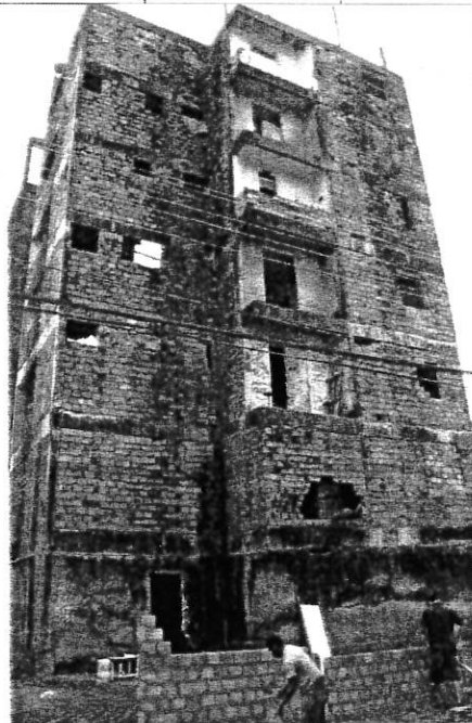
Muro está sendo construído em volta do "Balança, mas não cai"
