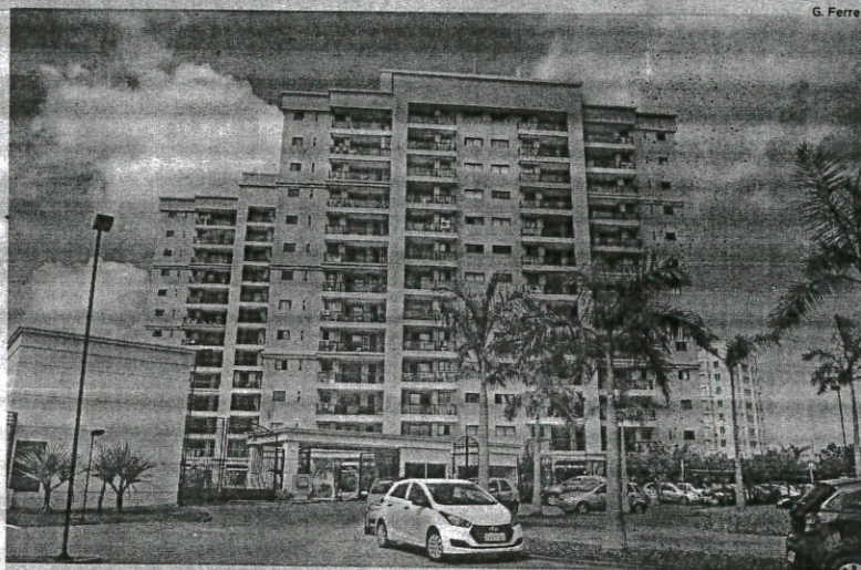
O Condomínio Jardim Toscana foi interditado na última terça-feira (27), por apresentar risco de explosão
