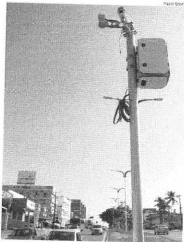
Equipamentos de sinalização estão sendo instalados em avenidas
