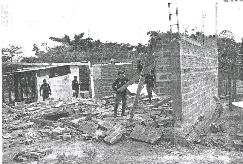
Homens da Blitz Urbana derrubam um dos imóveis construídos, de forma irregular, na área de preservação ambiental
