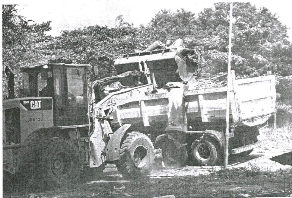
Um trator e uma caçamba foram utilizados para retirada dos destroços dos imóveis derrubados
