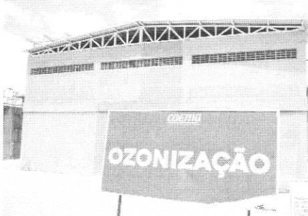
Fundamental no processo, a casa de ozônio não funciona nas ETEs
