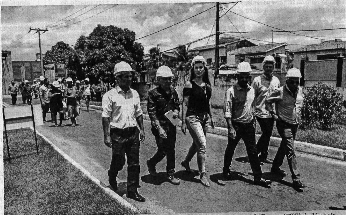
Deputados e técnicos da Caema fazem visita de inspeção à Estação de Tratamento de Esgoto (ETE) do Vinhais
