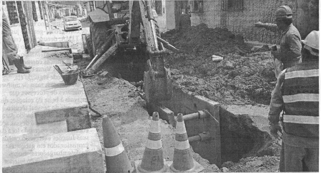
Operários da Caema trabalham em intervenção na rede de esgoto que passa pela Rua Dr. Carlos Macieira, no Coroado
