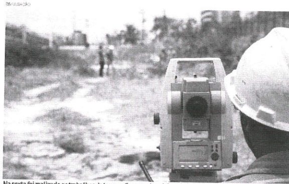
Na sexta foi realizado os trabalhos de topografia, para descrição e delimitação pormenorizada do terreno
