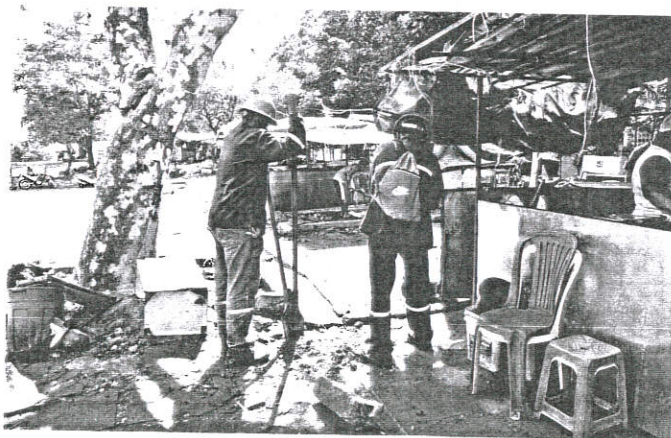
Operários escavam áreas onde serão implantados tapumes para que serviços avancem no entorno da praça
