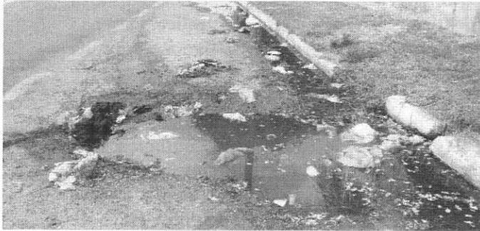
Bueiro sem tampa e entupido, próximo a escadaria, deixa água empossada no local; há risco de acidentes
