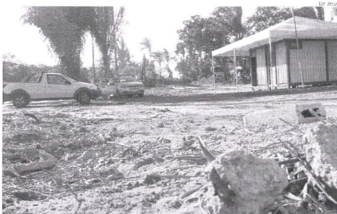
As intervenções de desmatamento no Sítio do Rangedor, no bairro do Calhau, já foram iniciadas
