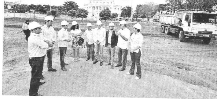
O prefeito Edivaldo Holanda Júnior vistoria as obras em companhia da presidente do Iphan, Kátia Bogéa
