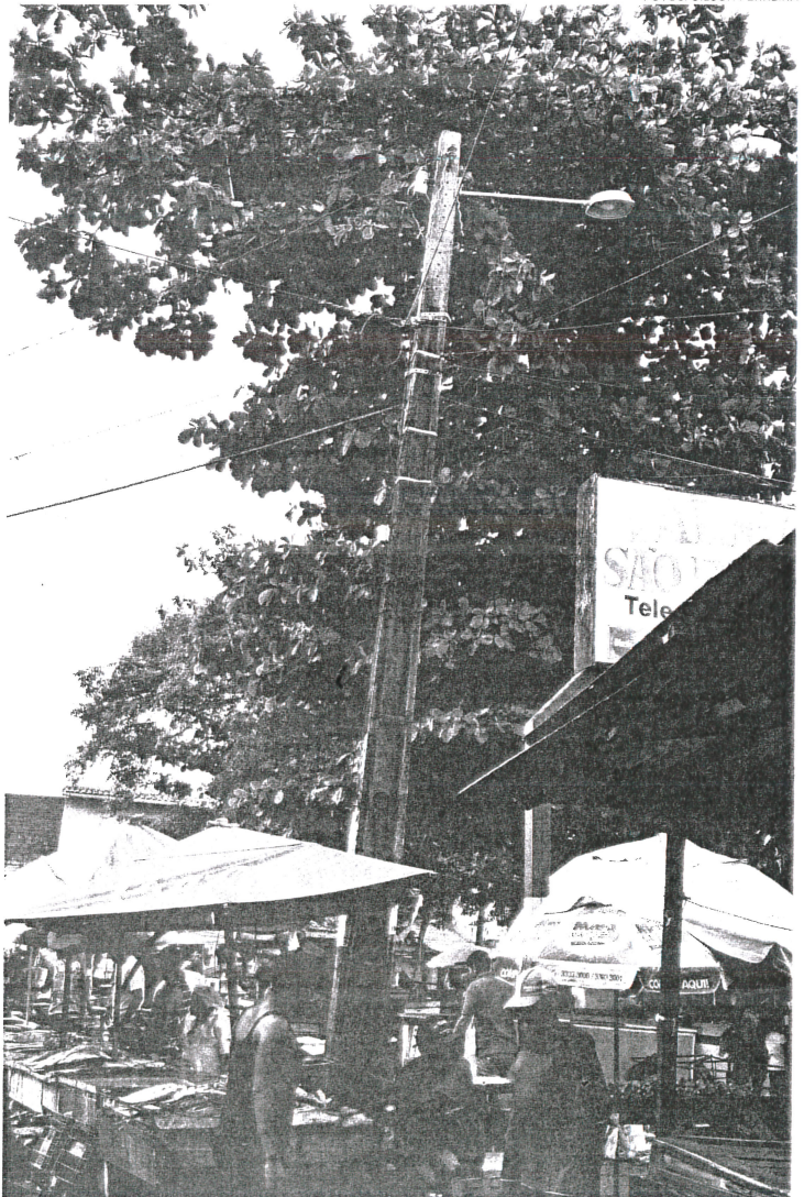
Poste localizado entre as bancas, na feira da Cidade Operária, apresenta risco de cair e preocupa comerciantes
