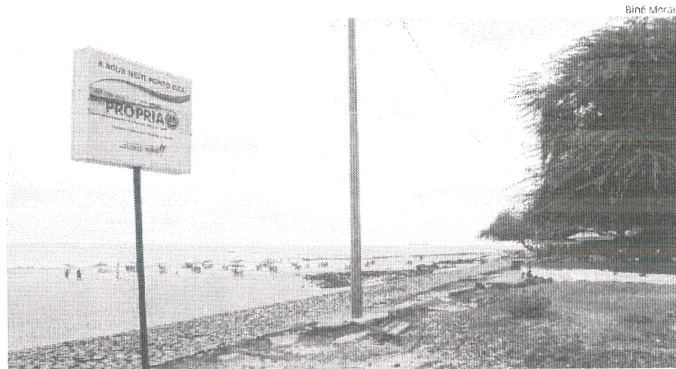
Trecho de praia impróprio continuava com placa de próprio, na manhã de sexta-feira, na Ponta d'Areia
