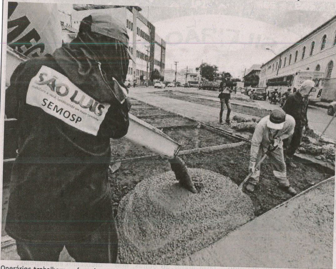
Operários trabalham na fase de concretagem do piso em espaço
