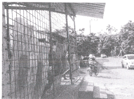
Comércio na zona rural funciona protegido por grades de ferro
