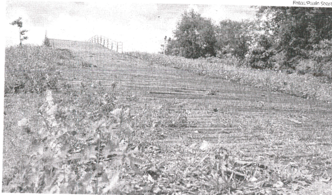
Ponte sobre o acesso ao Mirante da Lagoa está danificada e coberta de mato, por falta de manutenção no local
