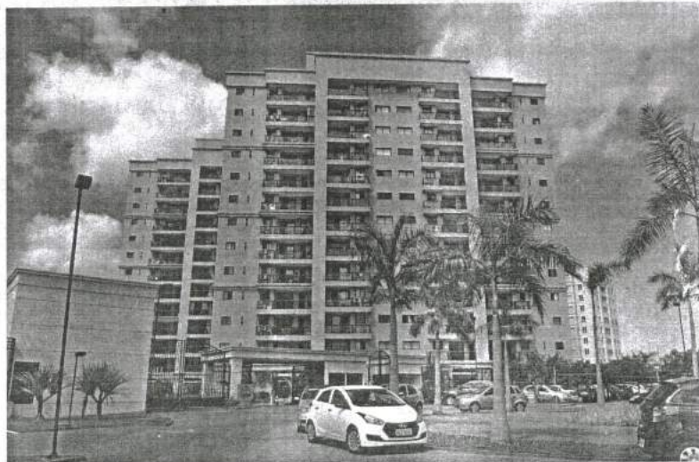
Moradores estão incomodados com novos problemas surgidos no condomínio da Cyrela
