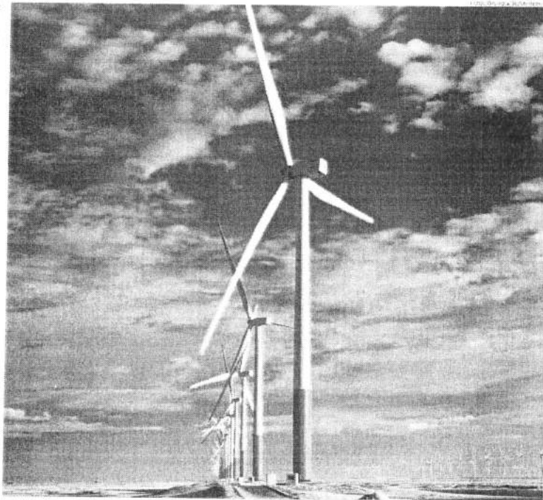
Instalação de aerogeradores do complexo Delta 3, na região de Paulino Neves e Barreirinhas, gerou 1,5 mil empregos diretos e 2 mil indiretos
