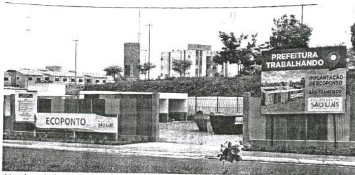
Moradores do São Francisco e bairros vizinhos parecem desconhecer a existência do ecoponto e descartam lixo em qualquer lugar
