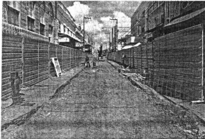
Obras de requalificação da Rua Grande começaram ontem, com a remoção dos paralelepípedos do calçamento da via.
