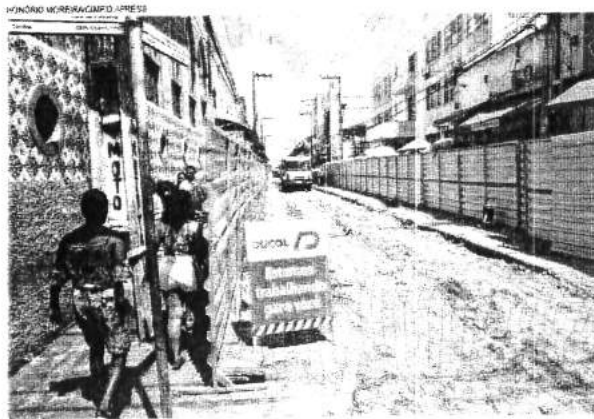
Obras da primeira quadra da Rua Grande começaram ontem alterando a rotina das pessoas na região
