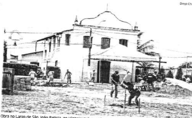
Obra no Largo de São João Batista, no Vinhais Velho, está sendo realizada por intervenção da comunidade
