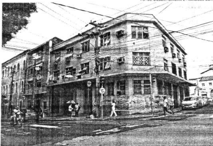
Em uma esquina da Rua do Egito, prédio que já abrigou Gerência da Previdência Social é ocupado por 16 famílias
