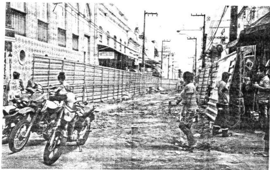
Trabalho lento na execução dos serviços de requalificação da Rua Grande tem deixado lojistas insatisfeitos; eles reclamam dos prejuízos que estão tendo, desde o início da obra, em abril
