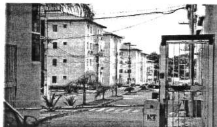
Área do Condomínio Vitória, apontado com possível risco de incêndio
