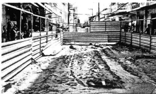
Primeira etapa da obra foi iniciada no dia 9 de abril e conclusão deveria ter ocorrido no dia 9 de junho
