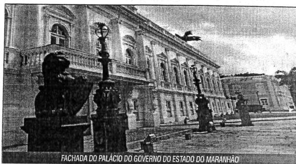
FACHADA DO PALÁCIO DO GOVERNO DO ESTADO DO MARANHÃO
