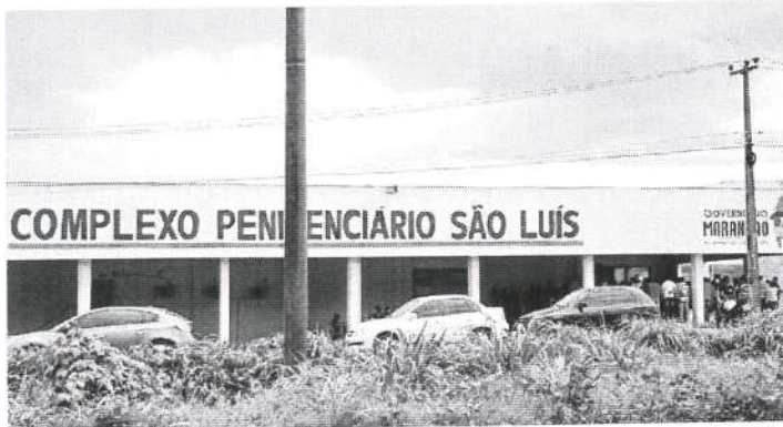
Fachada do Complexo Penitenciário de Pedrinhas, para onde presos deveriam ter retornado ontem
