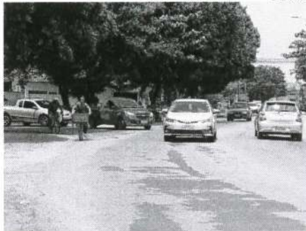
Não existe sinalização em trecho nas avenidas 4 e Joaquim Mochel
