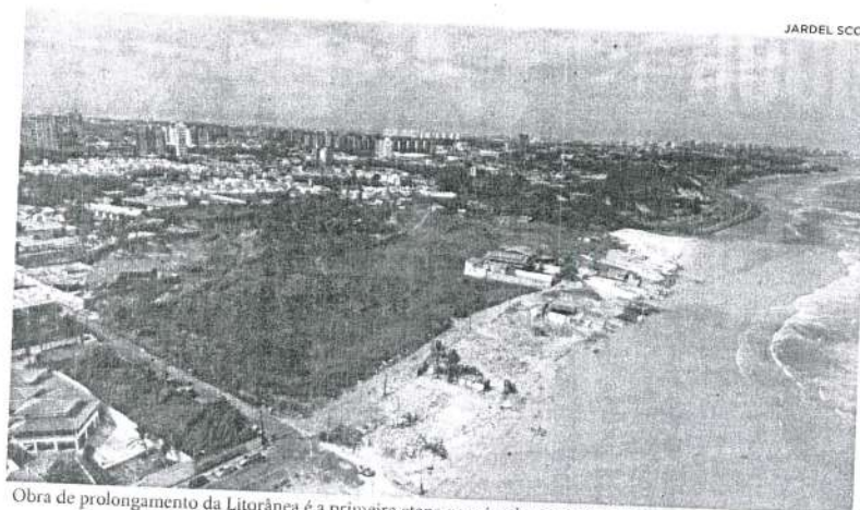
Obra de prolongamento da Litorânea é a primeira etapa para implantação do BRT
