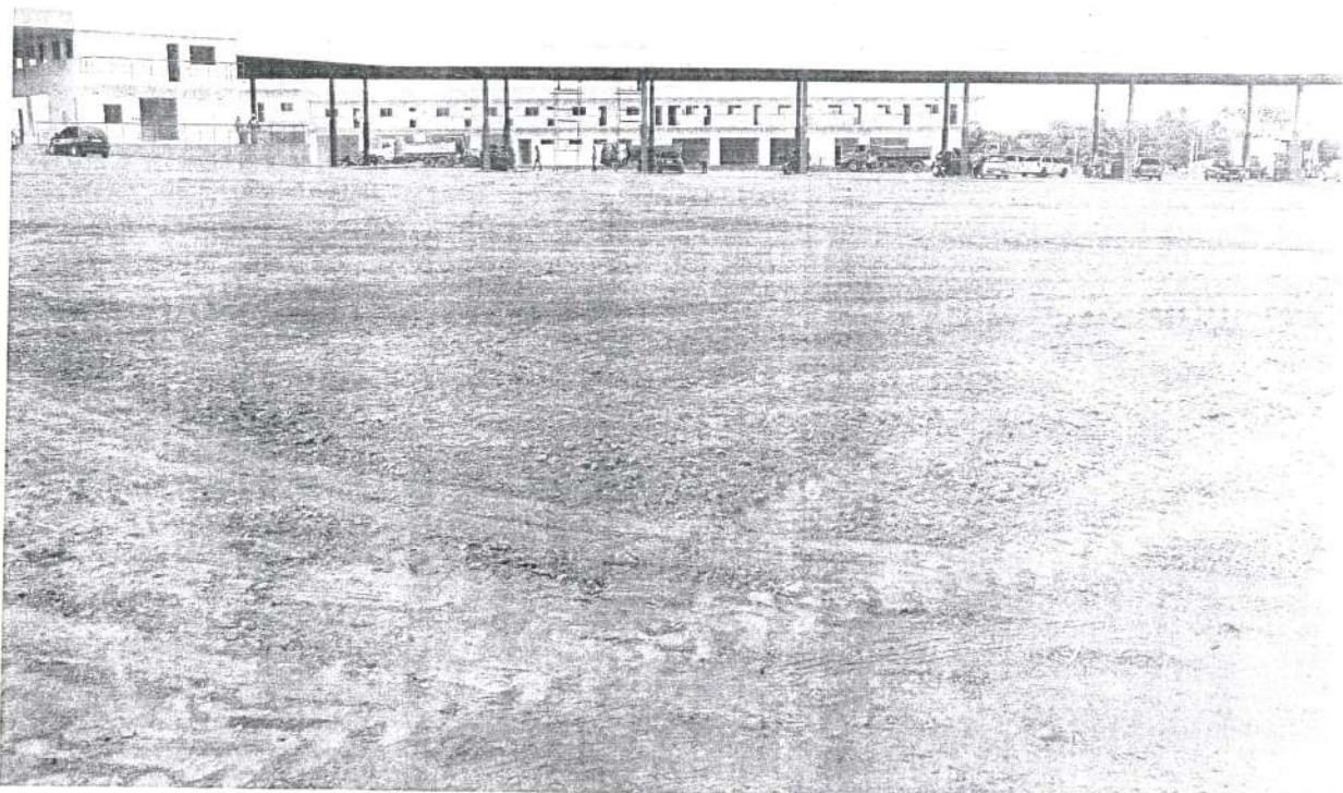
Moradores da comunidade Santa Rita, localizada na área do Rio dos Cachorros, em São Luís, se queixam de problemas ocasionados pela construção de posto de combustível
