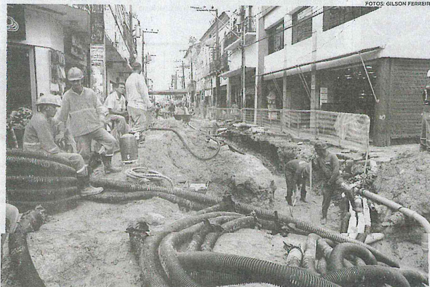
Devido às fortes chuvas, trabalhos na obra de requalificação da Rua Grande estão mais lentos e previsão de conclusão ficou para junho deste ano
