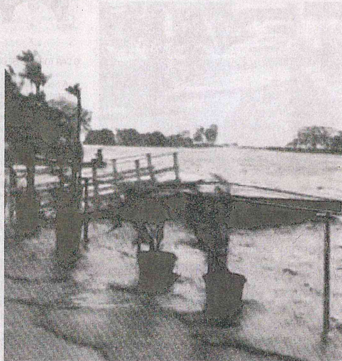
COM ROMPIMENTO DA BARRAGEM, O NÍVEL DO RIO PERICUMÃ SUBIU E ALAGOU CASAS
