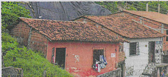
Contenção feita por moradores em área localizada na Vila Dom Luís, eles permanecem em suas casas
