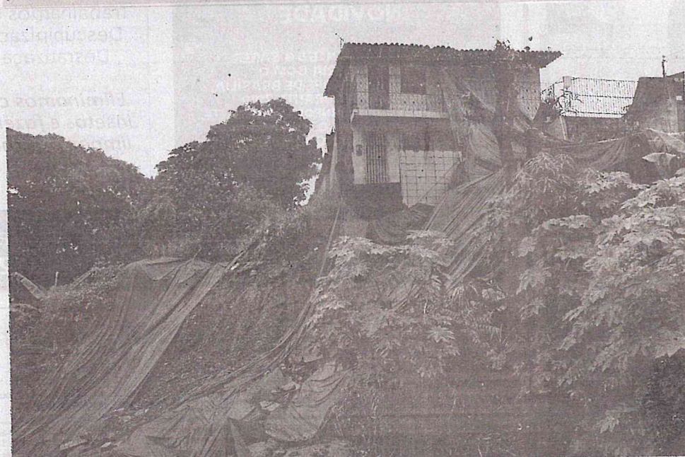
Na Rua São Luís, no Sacavém, um deslizamento de terra interditou casas e deixou famílias desabrigadas
